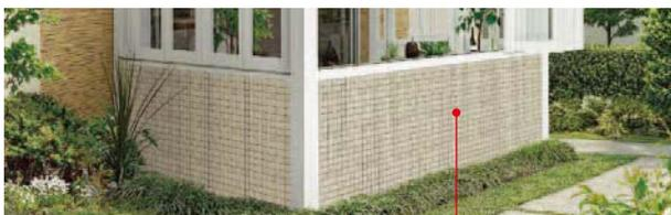
腰壁は、一般のコンクリートブロックと表面仕上げによる施工です。表面仕上げは市販されている、お好みのタイルまたは塗材よりお選びください。
